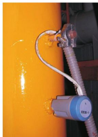
图 6 露点仪实物安装照片
